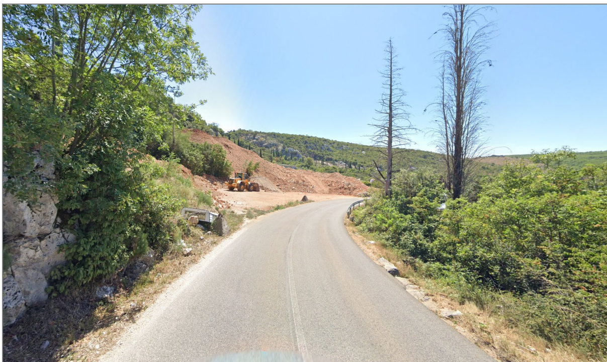
Grafički prilog 03. Lokalna cesta LC69048 u smjeru jugozapada te pogled na obuhvat južno od lokalne ceste Izvor: Google Maps, Urbanizam Dubrovnik d.o.o.
